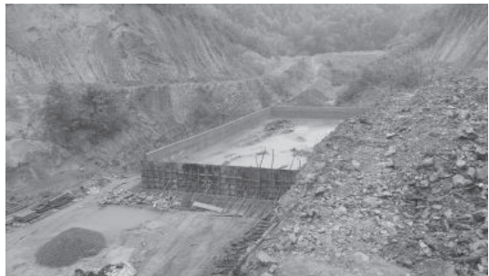
■ 그림 5-21 ■ 매립장내 침출수 저류조 공사현장
